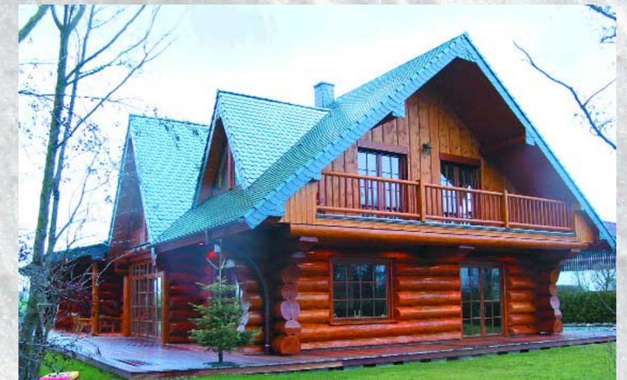
Die Giebelseite wurde in klassischer kanadischer Bauart mit Balkonen ausgestattet. Eine Douglasienverschalung aus breiten Schwartenprofilen schützt die Giebel.
