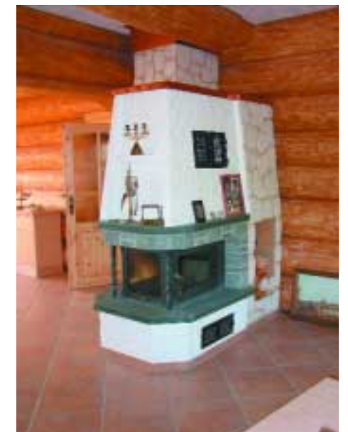
Der Selbstbauofen mit dreiseitigem Sichtfenster wurde vom Ofenbauer installiert.
