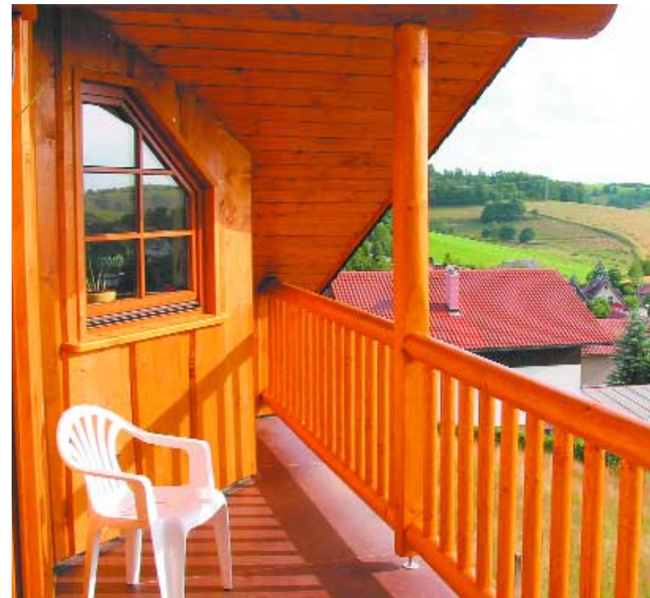
Die Holzarbeiten und Verglasung der Galerie übernahm der Blockhausbauer. Auf seine Idee ist auch das innenliegende Fenster mit Klappläden zurückzuführen.
