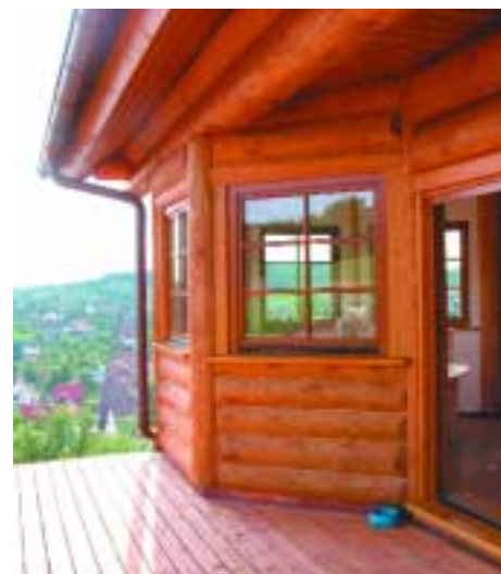
Der Erkeranbau ist eine Post & Beam-Bauweise mit einer Halbschalen-Verkleidung.
